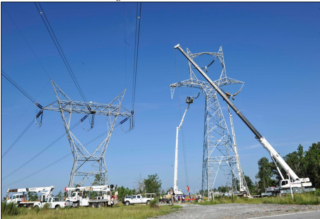
Photo 18 - 500kV Thomson-Vogtle Line Construction
